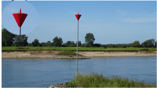
Een nieuw, vogelwerend baken langs de IJssel bij Zutphen.
